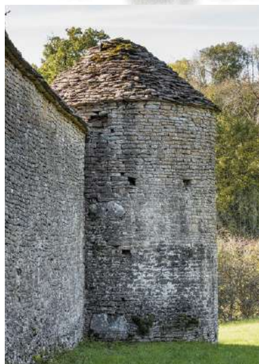
Tour d'enceinte du village de Salives (21)
